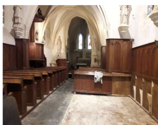
démontage des boiseries contaminées
